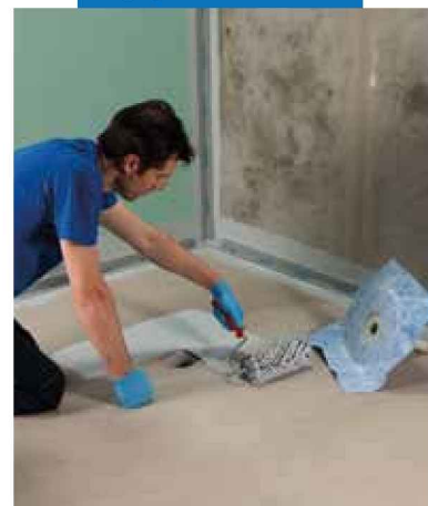
Установка Drain Vertical , используя Mapegum WPS
