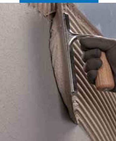
Укладка напольных покрытий, используя Ultramastic III
