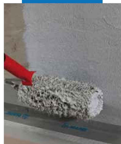
Нанесение Mapegum WPS с помощью валика
