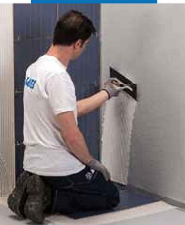
Укладка напольных покрытий, используя Keraflex Maxi S1
