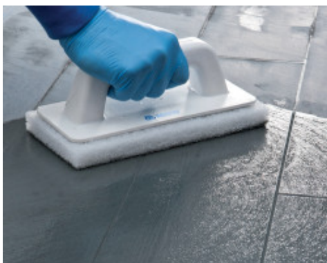
Формування швів губкою Scotch-Brite®, коли матеріал частково затужавів
