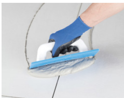
Нанесення матеріалу гумовим шпателем на облицьовану підлогу
